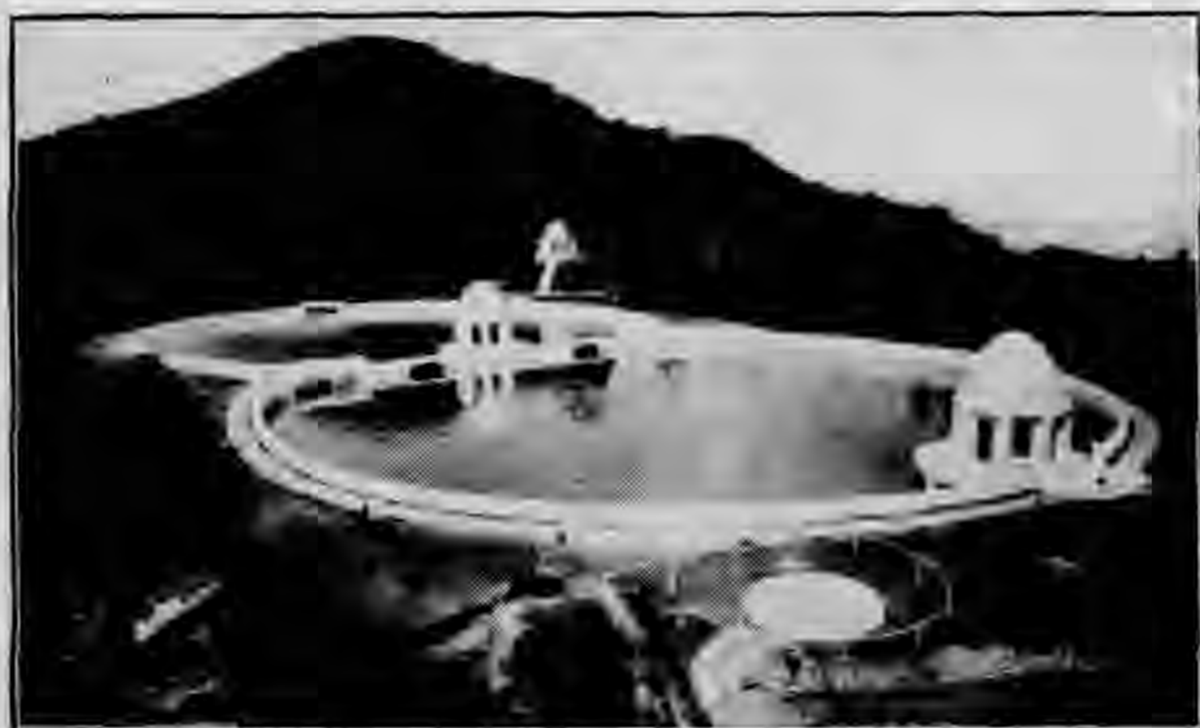
檳榔嶼新蓄水池
